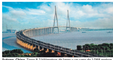
Sutong, China. Tiene 8,2 kilómetros de largo y un vano de 1.088 metros.
