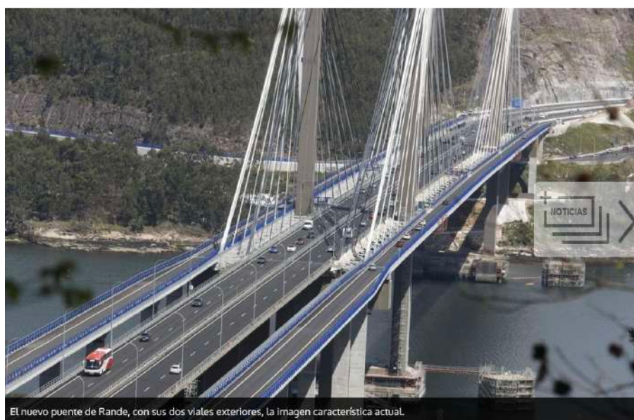
El nuevo puente de Rande, con sus dos viales exteriores, la imagen característica actual.
